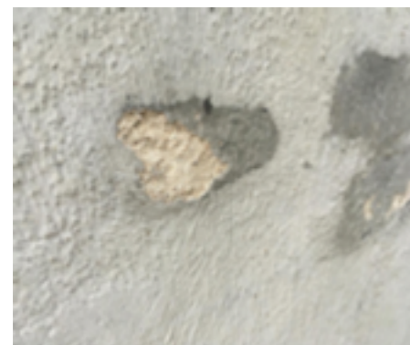
KLEUR GEVONDEN STUCWERK ONDER HUIDIGE GRIJZE CEMENTLAAG
