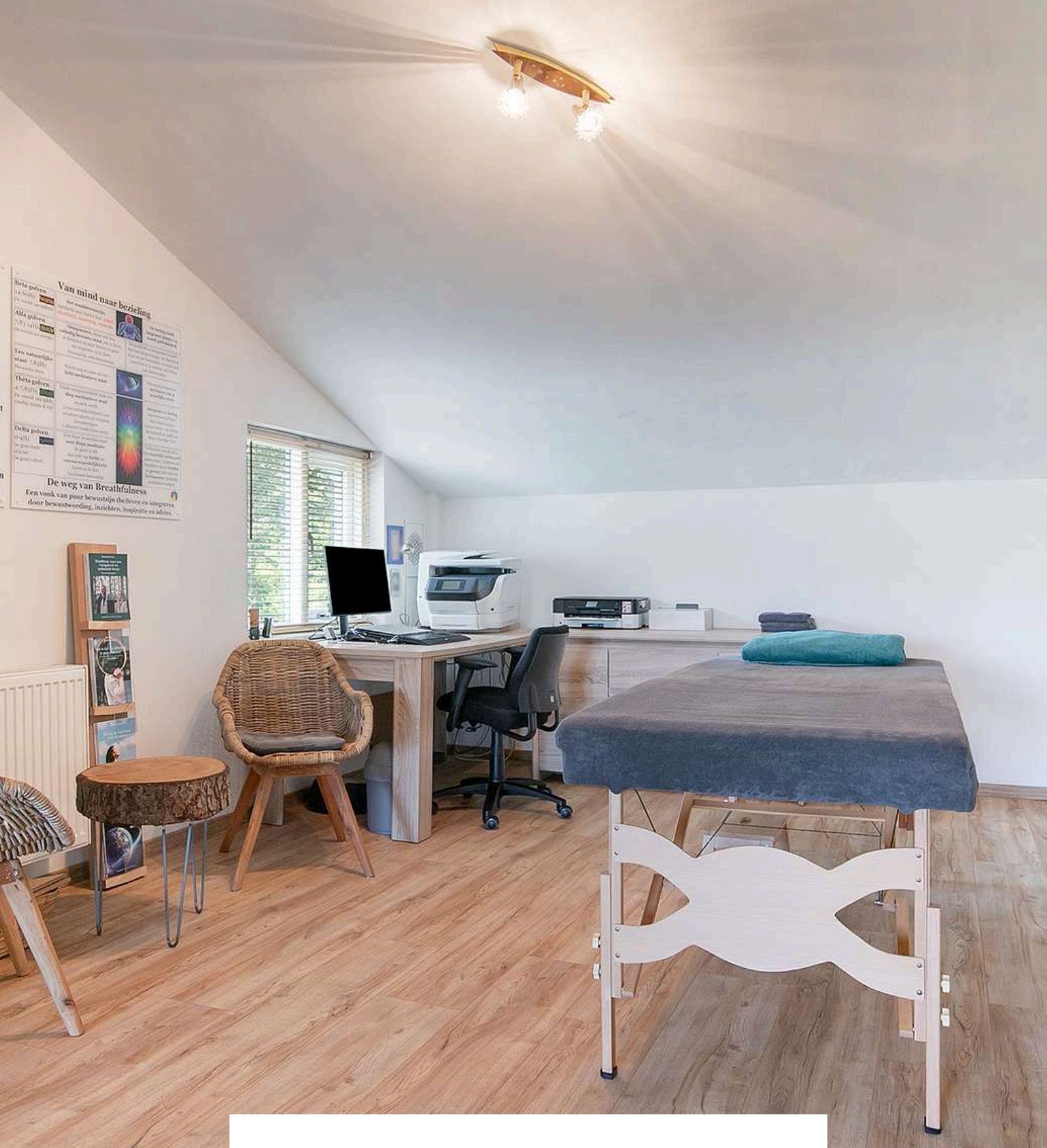
Slaapkamer 8 (Kantoor) is afgewerkt met een laminaat vloer, spachtelputz wanden en een gestuct plafond.
