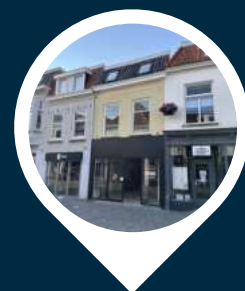
Nieuwbouw store Wouwsestraat 17 4611 PK Bergen op Zoom
