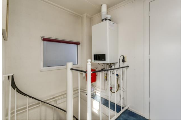
Overloop 2 e verdieping
